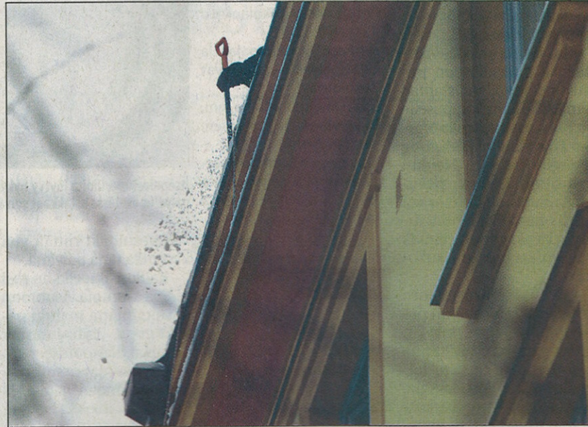
Lumen pudottamisessa katoilta pitää käyttää ammattitaitoista, kattotöihin erikoistunutta työvoimaa.
